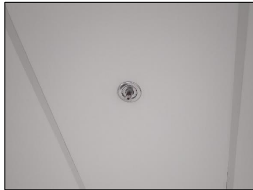
รูปที่ 33 หัวกระจายน้ำดับเพลิง
