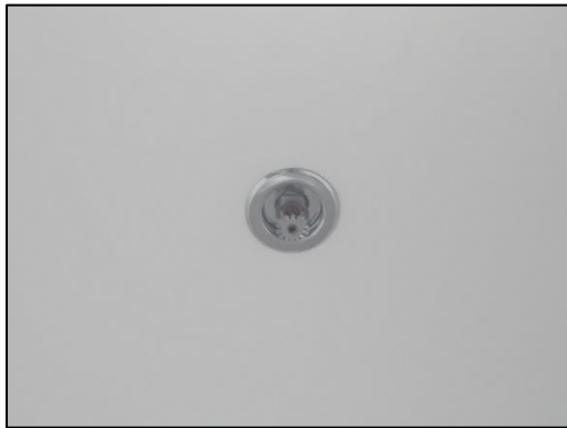
รูปที่ 33 หัวกระจายน้ำดับเพลิง
