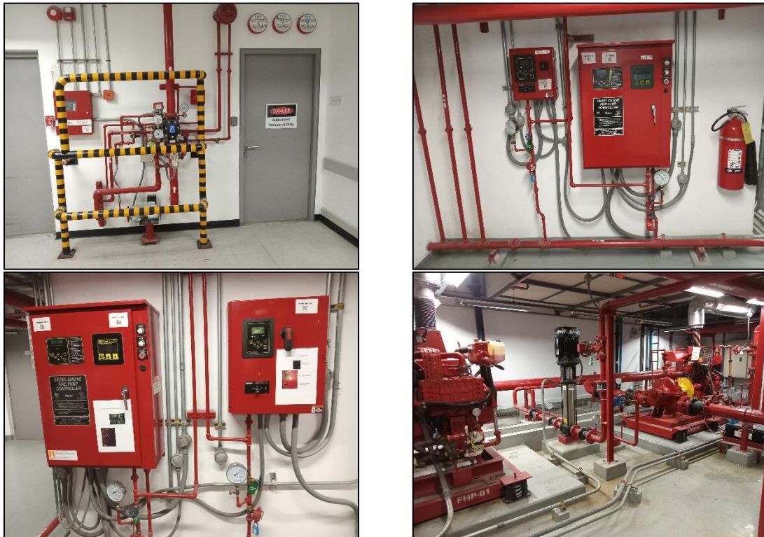
รูปที่ 29 เครื่องสูบน้ำดับเพลิงและระบบท่อน้ำดับเพลิง
