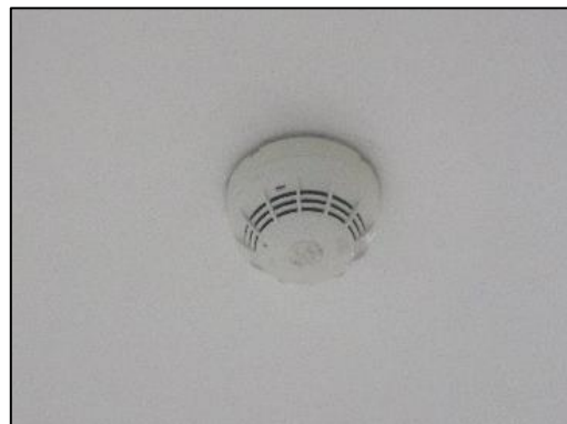
รูปที่ 35 เครื่องตรวจจับควัน
